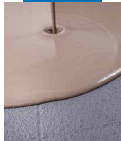
Полагане на саморазливен загладяващ разтвор върху сух Eco Prim Grip Plus върху стар под
