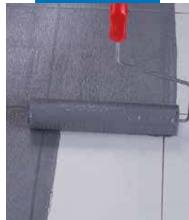
Полагане с валик на Eco Prim Grip Plus върху съществуващи керамични плочки
