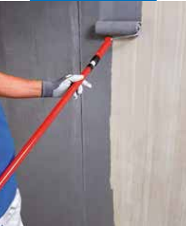
Нанасяне с валик на Eco Prim Grip Plus върху бетон
